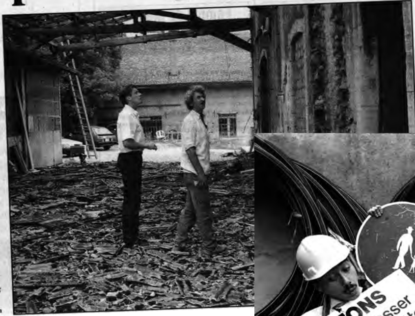
Début des travaux à l'Usine à gaz: plus qu'une ossature sur un tapis de débris. photo c. guyot-noth
